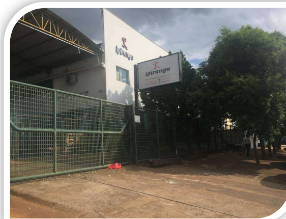
Fonte: Área Externa da Recuperanda.
