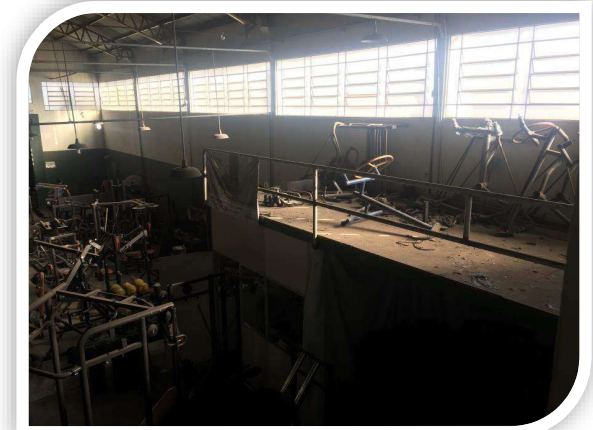
Fonte: Área Operacional da Recuperanda.
