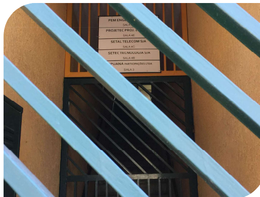
Fonte: Área Externa da Recuperanda.
