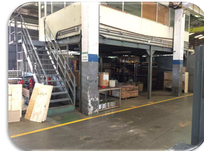
Fonte: Área Operacional da Recuperanda.
