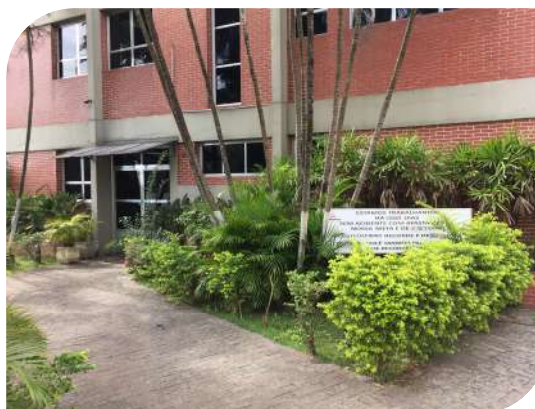
Fonte: Área Externa da Recuperanda.
