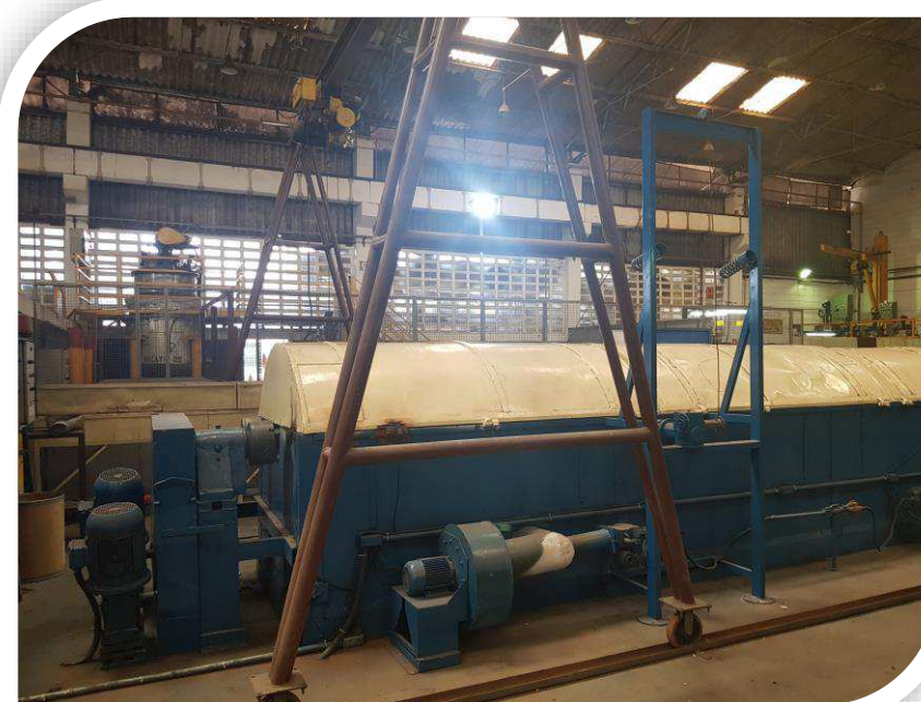
Fonte: Área Operacional da Recuperanda.
